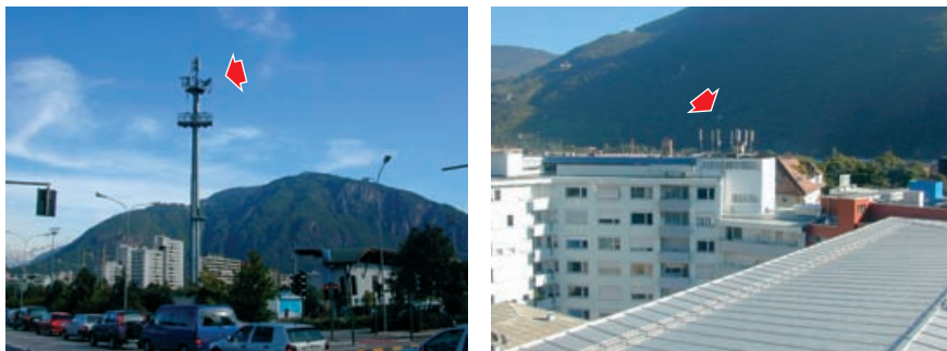
Fig 1) Stazioni di radiobase per la telefonia mobile. Sono costituite di regola da diverse antenne di trasmissione e ricezione, solitamente montate su tetti di edifici, piloni per l'illuminazione, tralicci o quant'altro.
