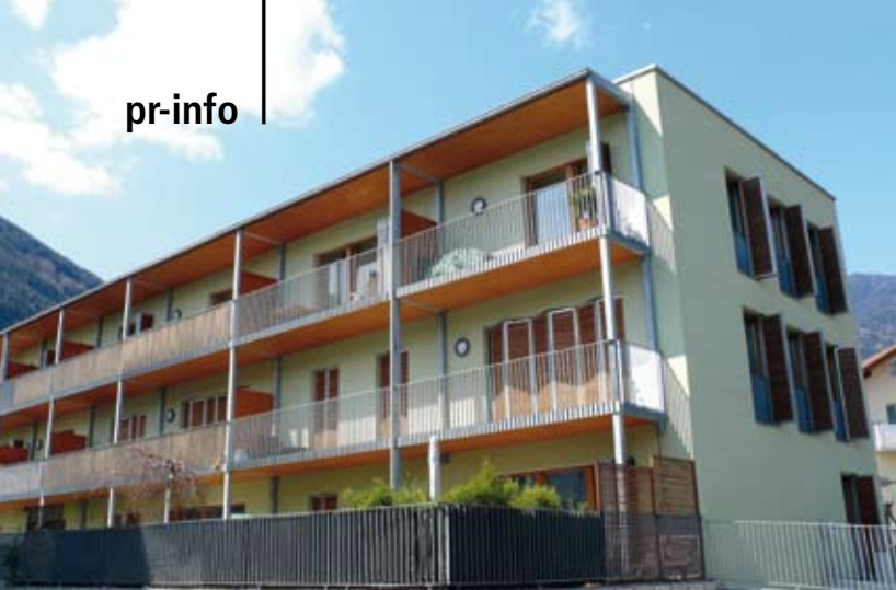
Als KlimaHaus Gold plus kommt das Wohnhaus Faller in Vahrn mit nur 9 kWh/(m 2 a) Jahresheizwärmebedarf aus
